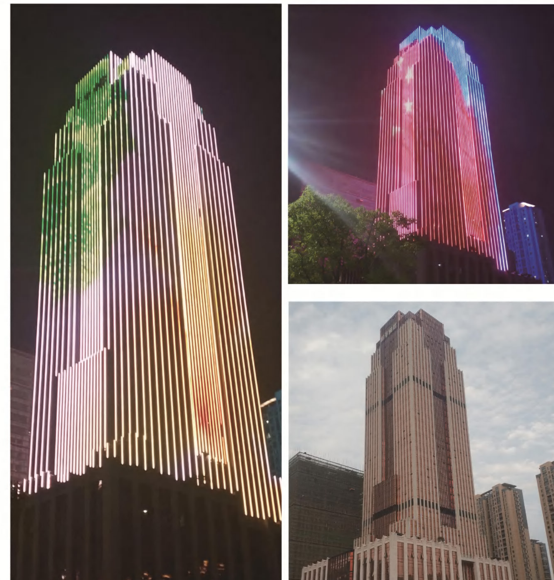
项目名称：明华国际 开工日期：2018年2月
