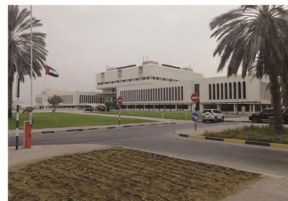
项目名称:阿布扎比政府楼体亮化 开工日期:2018年7月
